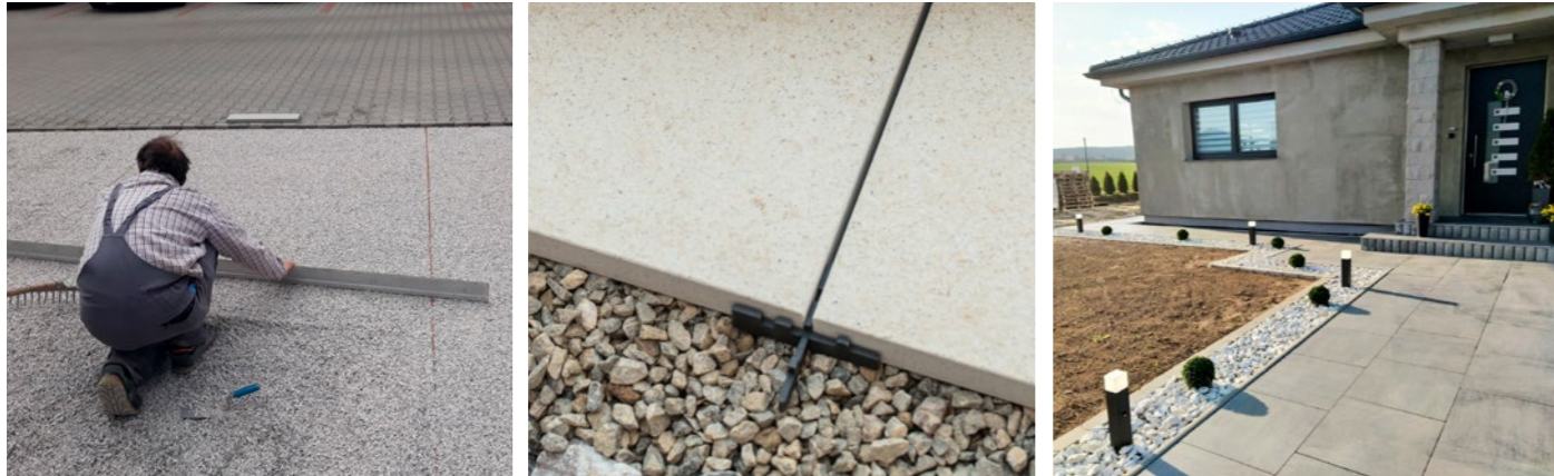
Bild 28, 29 und 30 Verlegung auf Kies
