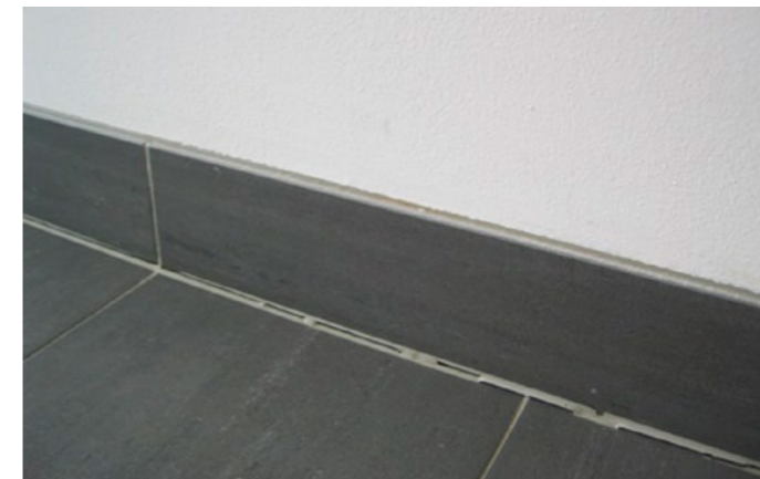
Bild 26 Gerissene Dehnungsfuge ohne Verwendung des Trennseils
