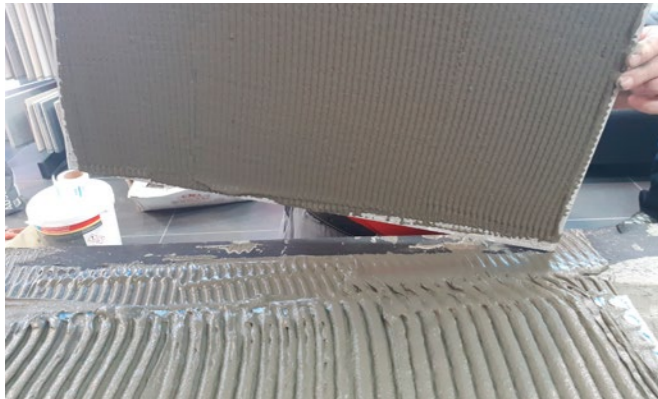
Bild 10 Kleben im Buttering-floating verfahren
