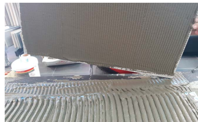
Obr. 10 Lepení metodou buttering-floating
