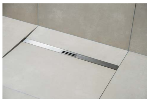
Obr. 22 Použití formátu 80 × 80 cm s vyspádovanou podlahou
