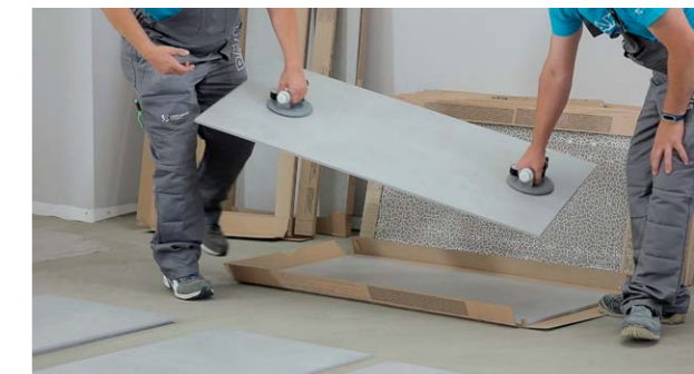
Obr. 7 Přísavky na velké formáty
