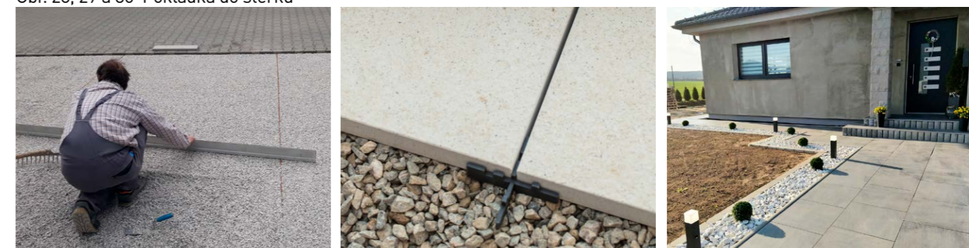
Obr. 28, 29 a 30 Pokládka do štěrku
