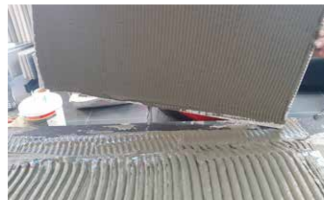
Obr. 10 Lepení metodou buttering-floating
